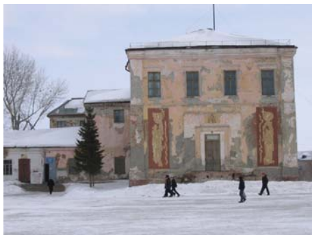
Разрушенное здание Дома культуры в г. Щучье
