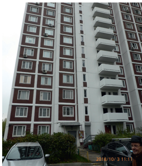
Рис. 2. Вид пилотного дома после капитального ремонта фасада
