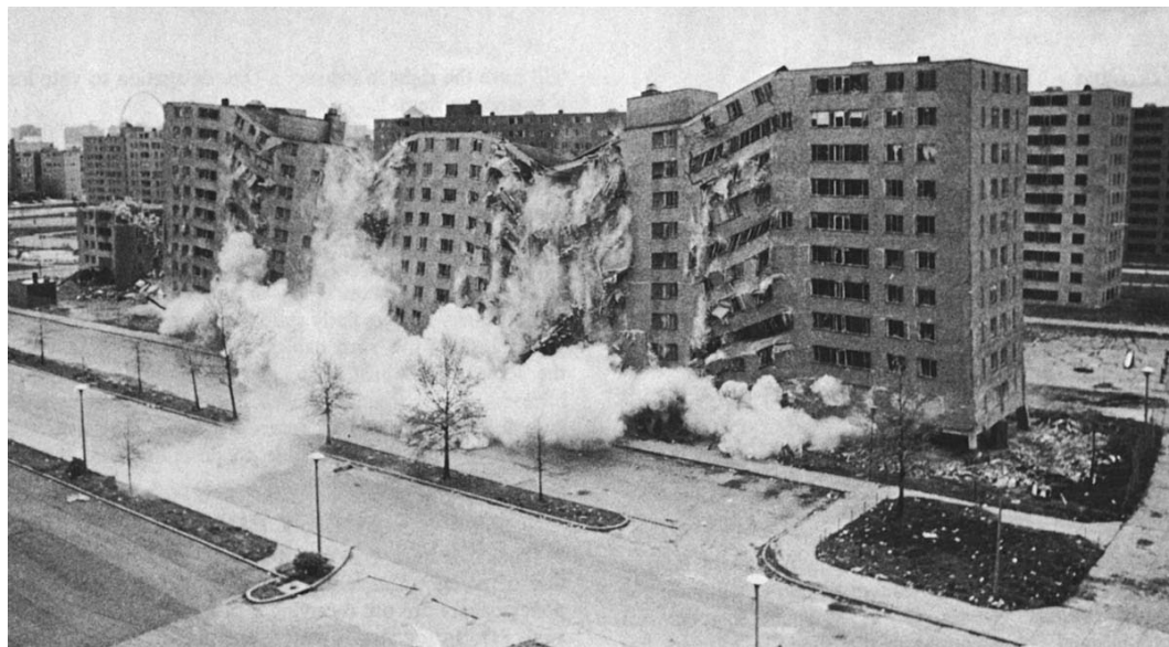
Рисунок 2 – Снос жилого комплекса Pruitt-Igoe (Сэйнт Луис, штат Миссури) 16 марта 1972 г., через 16 лет после его строительства
