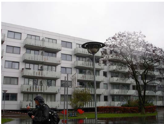
Здание жилищной ассоциации реконструировано для увеличения квартир (по числу комнат и площади). Фасад облицован, лоджии и балконы застеклены
