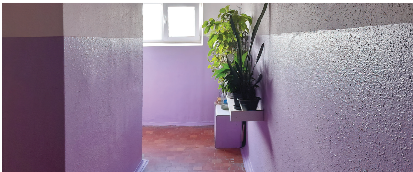
Фото 3. МКД по ул. Набережная, 51 – отремонтированные лестничные площадки. Фото: ИЭГ
