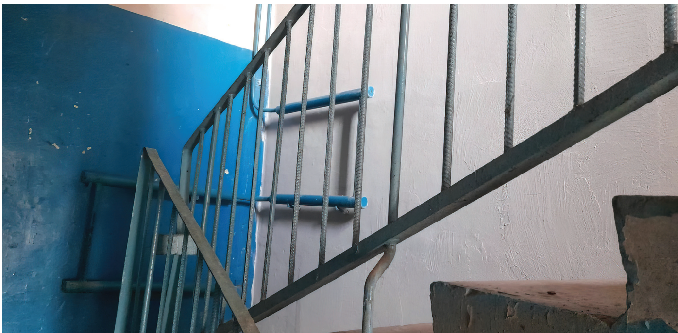
Фото 4. Окраска стены лестничного пролета в МКД по ул. Промышленная, 55 специальной теплоизолирующей мастикой. Фото: ИЭГ
