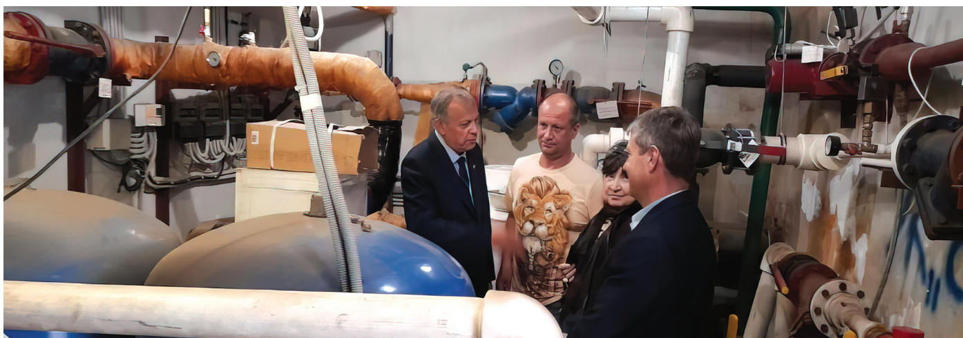
Фото 5. Отремонтированный в рамках капитального ремонта тепловой узел в подвальном помещении МКД по ул. Южакова, д. 2. Фото ИЭГ
