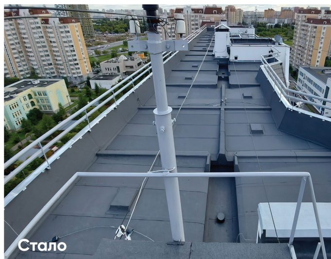
Фото 2. Капитальный ремонт кровли дома. Фото предоставлено советом многоквартирного дома
