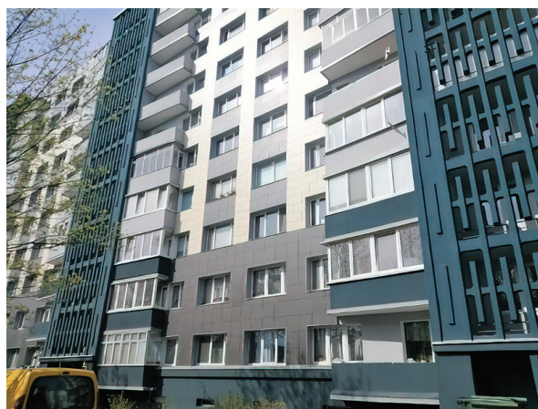
Фото 1. Фасад многоквартирного дома №№ 25-29 по ул. Эпроновская (г. Калининград) после капитального ремонта с утеплением. Фото: ИЭГ
