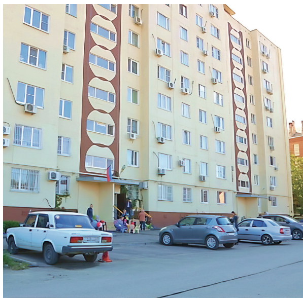
Фото 1. Многоквартирный дом № 4 по ул. Башкирская, г. Ростов-на-Дону. Фото предоставлено правлением ТСЖ «Башкирская-4»
