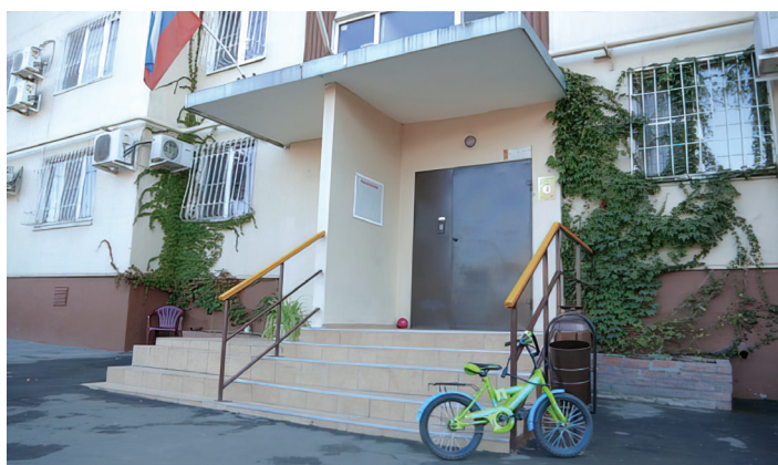
Фото 2. Входная группа в подъезд МКД после капитального ремонта. Фото предоставлено управлением ТСЖ «Башкирская-4»
