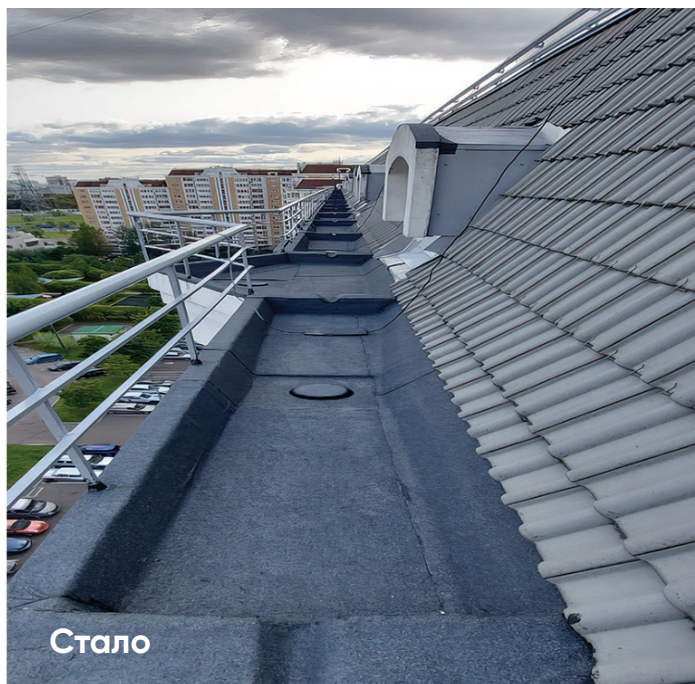
Фото 3. Капитальный ремонт кровли ложных балконов дома. Фото предоставлено советом многоквартирного дома
