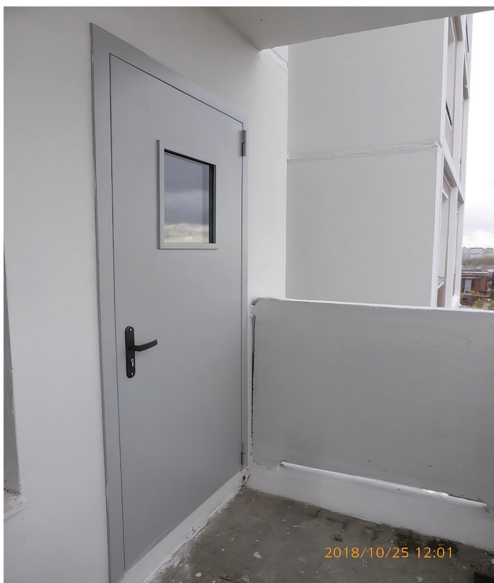
Фото 10 и 11. Двери на балконах пожарных лестниц после проведения капитального ремонта. Фото предоставлены советом МКД.
