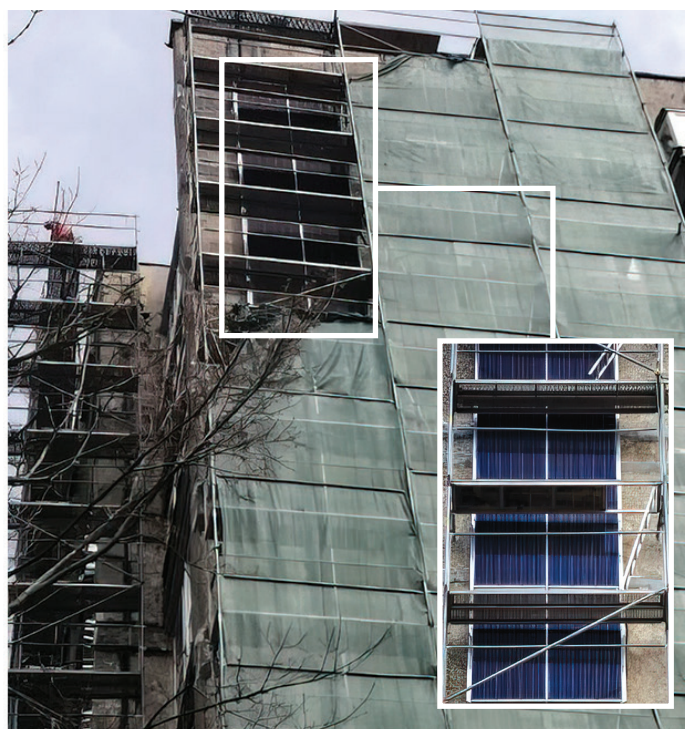
Фото 3-4. Многоквартирный дом № 18 по ул. Маршала Баграмяна (г. Калининград) в процессе капитального ремонта. На фасаде установлены солнечные батареи. Фото: ИЭГФото:
