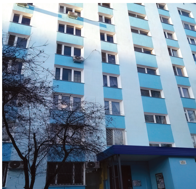
Фото 4. Состояние фасада многоквартирного дома после капитального ремонта. Фото предоставлено правлением ЖСК «Эмблема».
