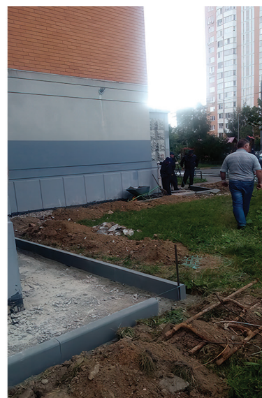
Фото 5–7. Работы по ремонту отмостки в МКД по улице Перовская, дом 22, корпус 2. Фото предоставлено правлением ТСЖ «Перовская 22 корпус 2».
