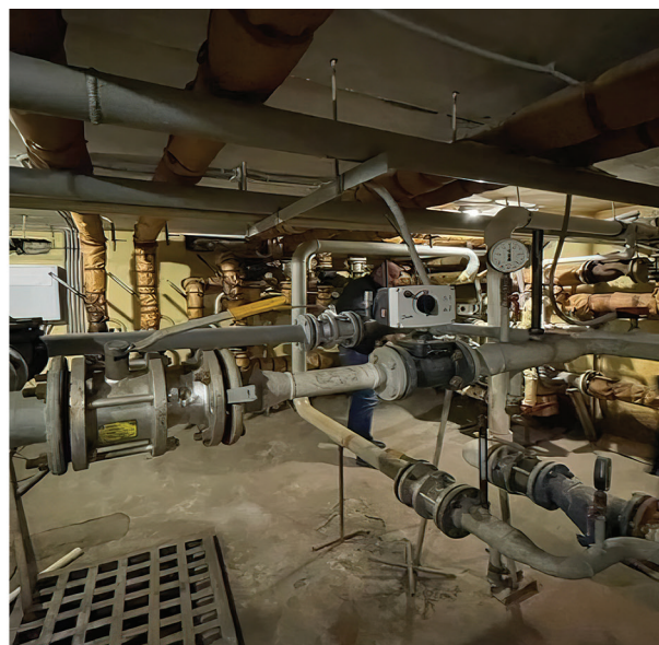
Фото 2–3. Насосно-циркуляционная система отопления в МКД по проезду Моторостроителей, д. 2. Фото: ИЭГ.
