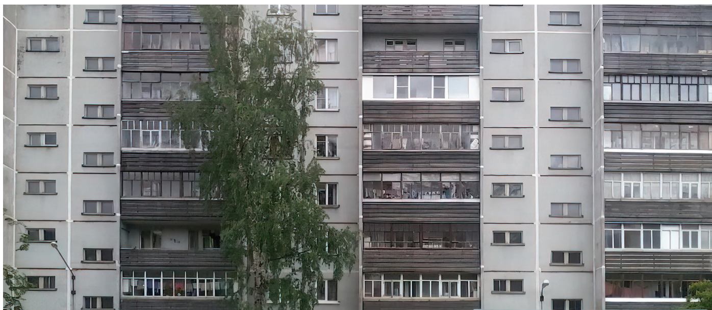
Фото 2. МКД по ул. Набережная, 51 – герметизация межпанельных швов. Фото: Wikimapia.
