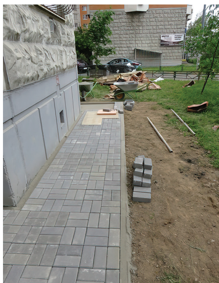
Фото 5–7. Работы по ремонту отмостки в МКД по улице Перовская, дом 22, корпус 2. Фото предоставлено правлением ТСЖ «Перовская 22 корпус 2».
