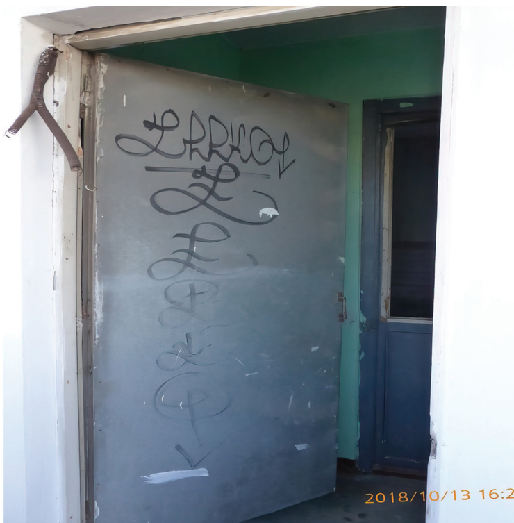
Фото 8 и 9. Двери на балконах пожарных лестниц до проведения капитального ремонта. Фото предоставлены советом МКД.
