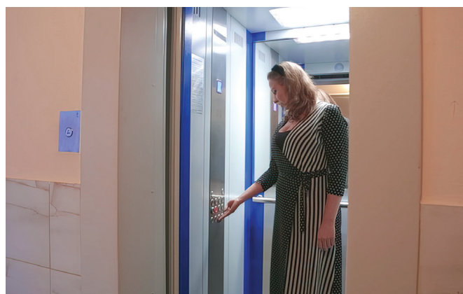
Фото 3. Новые лифты в МКД № 4 по ул. Башкирская, г. Ростов-на-Дону. Фото предоставлено управлением ТСЖ «Башкирская-4»
