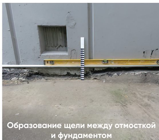
Фото 2–4. Дефекты отмостки и фундамента в МКД по улице Перовская, дом 22, корпус 2. Фото предоставлено правлением ТСЖ «Перовская 22 корпус 2»
