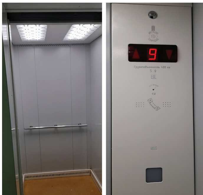
Фото 3–4. Новые лифты МКД по адресу площадь Мира, дом 2. Фото ИЭГ
