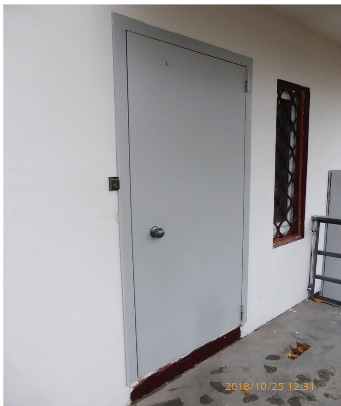
Фото 10 и 11. Двери на балконах пожарных лестниц после проведения капитального ремонта. Фото предоставлены советом МКД.
